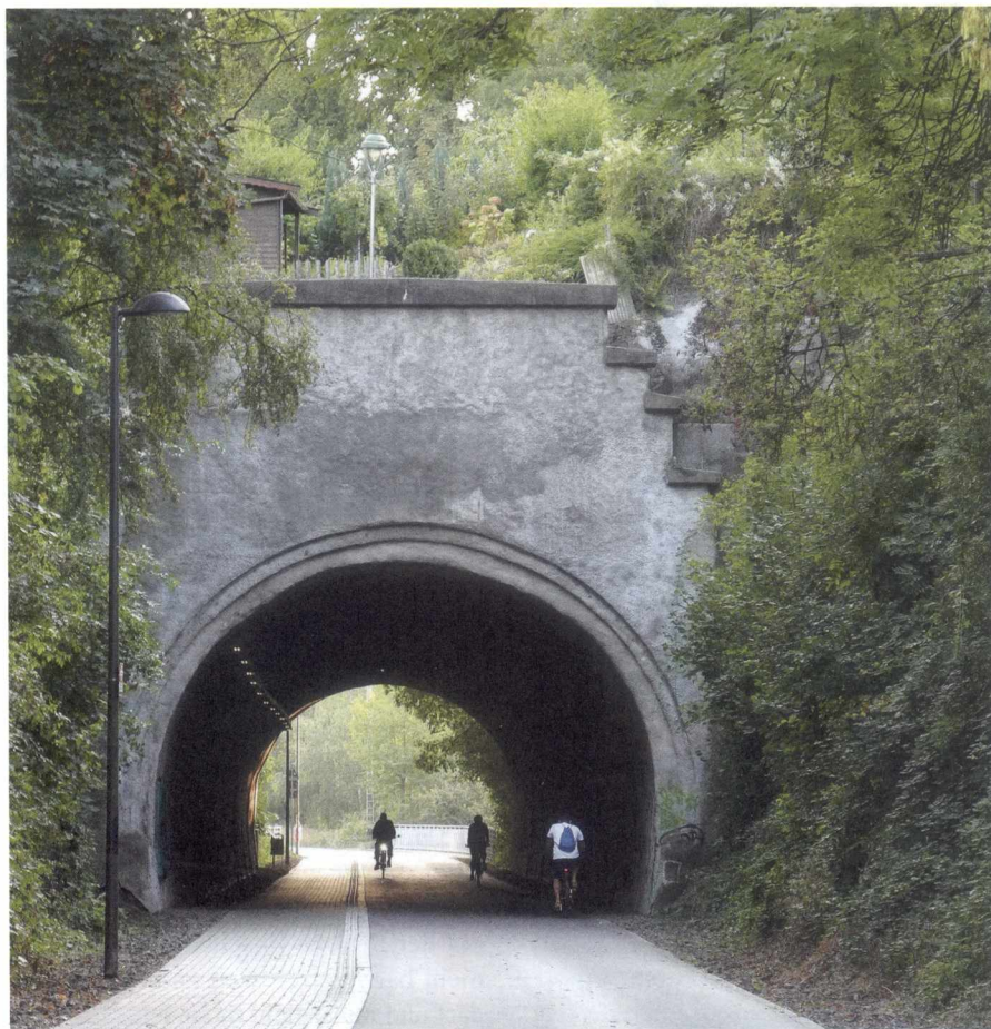
Fatloht-Tunnel der Wuppertaler Nordbahntrasse Foto: Im Fokus / Wikimedia Commons [CC BY-SA 4.0]
